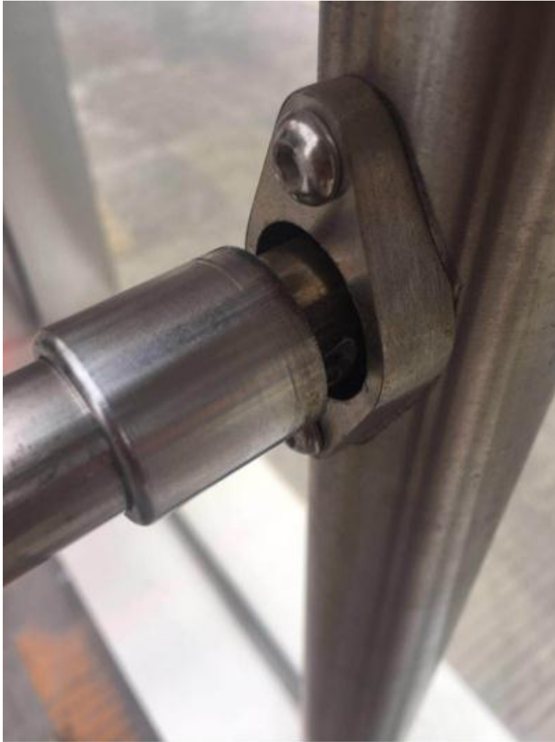
图2-7 门翼固定螺丝松动
